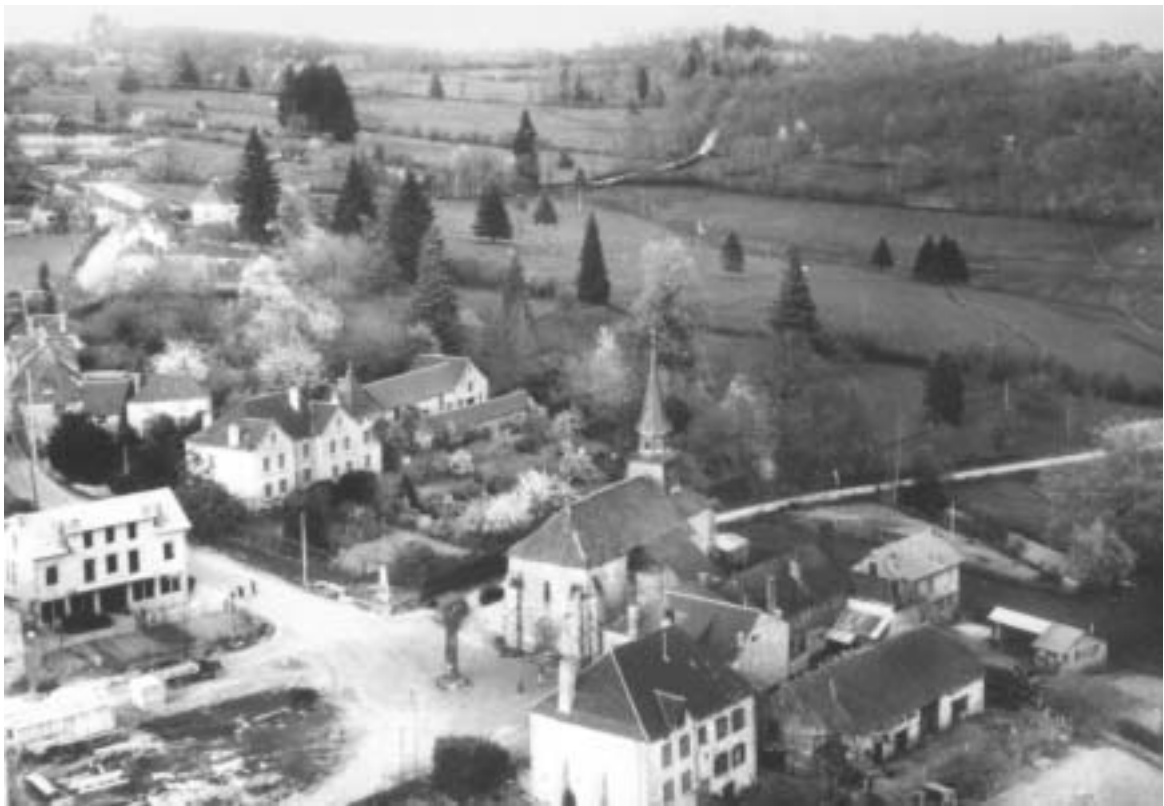
Construction de la Mairie.
